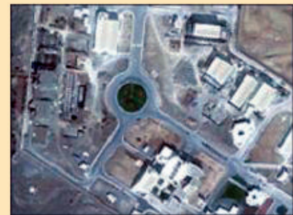
Natanz Uranyum Zenginleştirme Tesisi (uydu görüntüsü)
